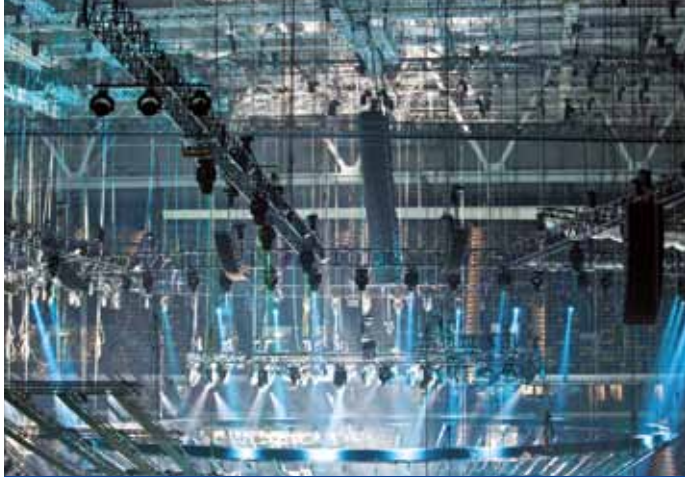
Die zahlreichen abgehängten Line-Arrays mit d&b-Lautsprechern der Serien Q, J und T
