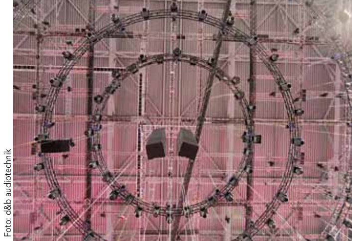
Die mit Moving Lights bestückten drei Traversen-Ringe in 20 m Höhe über der Center Stage
